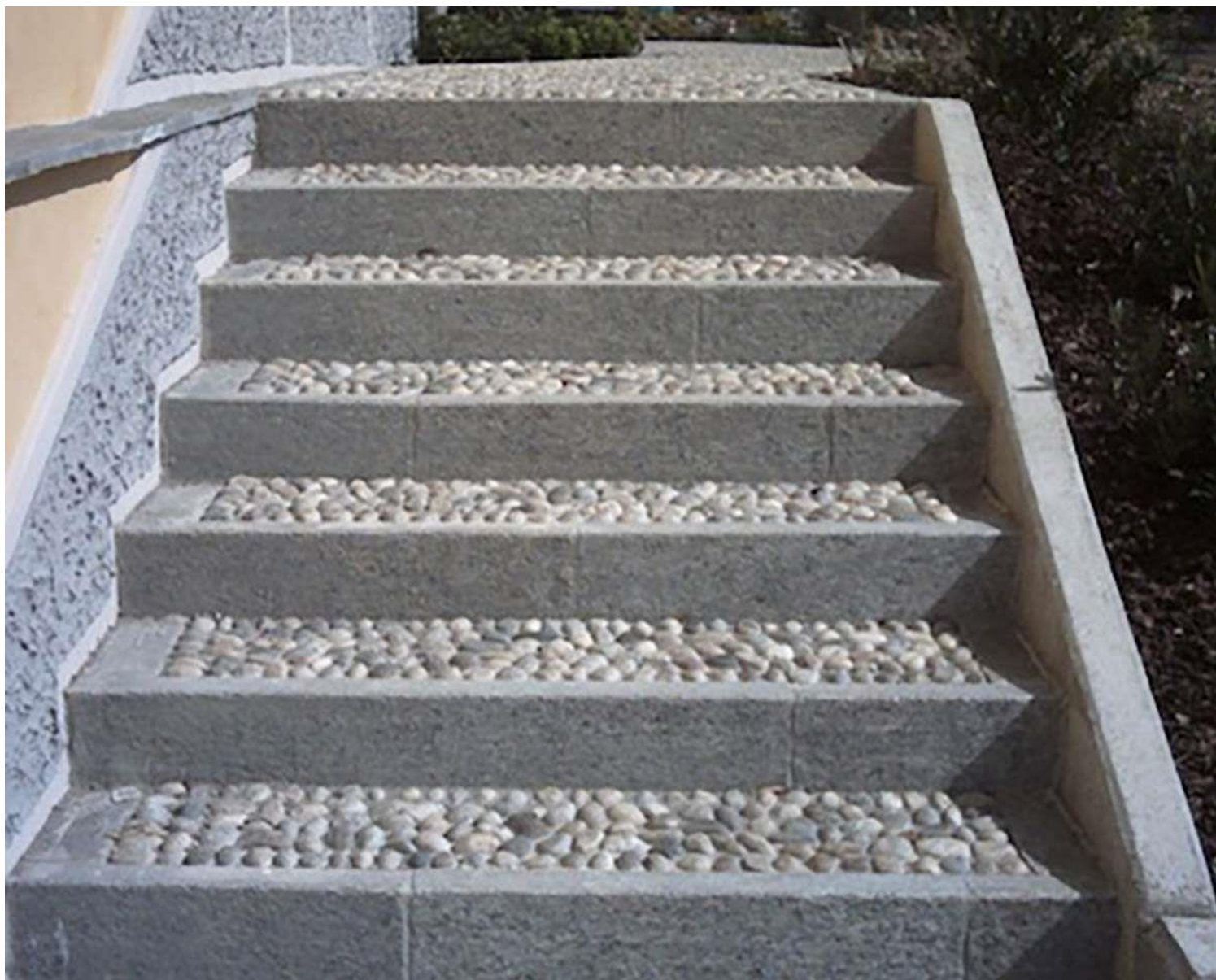
scala-alzate-in-granito-pedate-in-ciotolato
